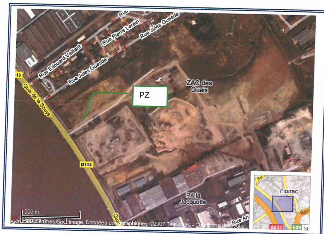
Figure 3 : Vue aérienne de la ZAC des Quais - Floirac
