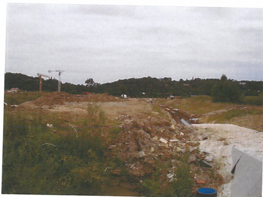
Illustration chantier de la ZAC des quais - Floirac
